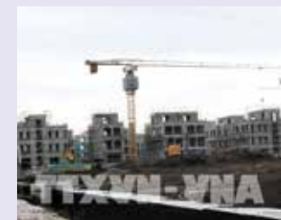
Thị công dự án công trình đầu tư du lịch tại huyện đảo Phú Quốc. Ảnh: Lê Huy Hải - TTXVN
