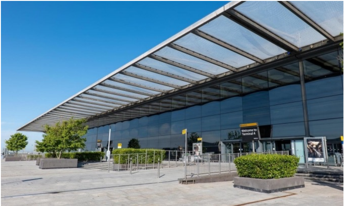
Nhà ga Terminal 4 - sân bay quốc tế London Heathrow (LHR), London. Ảnh: London Heathrow Airport
