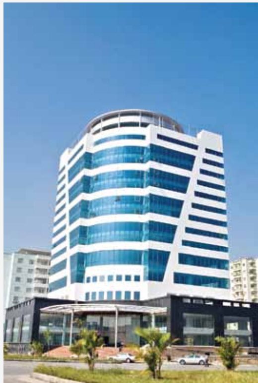
TÒA NHÀ TRỤ SỞ CHÍNH CÔNG TY THÔNG TIN DI ĐỘNG MOBIFONE ĐƯA VÀO SỬ DỤNG 2010
