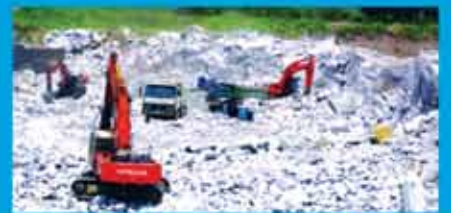
Công trường khai thác đá
